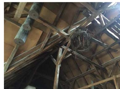
Aufgehende Wandbereiche wie zum Beispiel im Bereich der Giebel sind ebenfalls nicht gedämmt. Der Zustand der Dachhaut scheint augenscheinlich in Ordnung zu sein, wobei im Gebäude Wasserschäden vorgefunden wurden, wie zum Beispiel im Oberschoss im Bereich der Giebelanlage.
