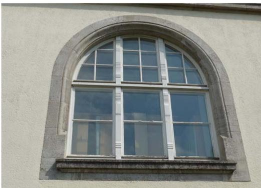
Exemplarische Abbildung eines sanierungsbedürftige Fensters, zum Teil mit starken Farbabplatzungen /fehlender Anstrich - Handlungsbedarf – ungeschützte Wasserschenkel – Feststellung des Schädigungsgrades erforderlich
