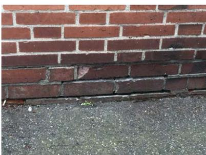
Bild 8, 9, 10 geschädigte Sockelbereich, offen Fugen mit Frostschäden
