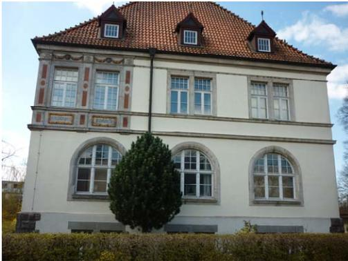
Kapillarfugen im Bereich der Fenstereinfassungen, die zu Frostschäden führen bzw. führen können. Der Fensterbereich des Kellergeschosses liegt im Spritzwasserbereich. Der Pflasterbelag wird direkt an das Fensterelement geführt. Verschmutzte Sockel- und Fassadenbereiche der Putzfassade – Anstricherneuerung der Putzfassade und Aufarbeitung der historischen Stilelemente notwendig.
